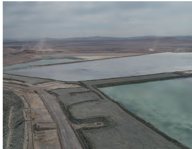
Actuaciones para Minera Spence. Chile.
