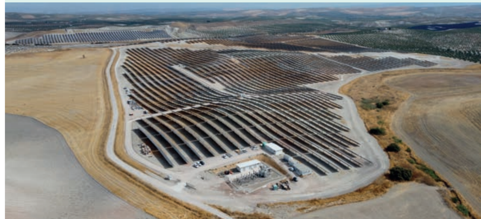
Planta fotovoltaica Olivares, 50MW. Jaén, España.
