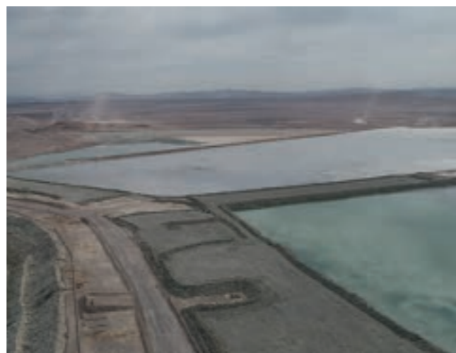
Actuaciones para Minera Spence. Chile.
