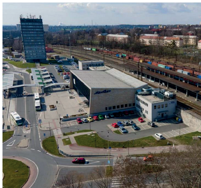
Estación de Havířov donde se llevarán a cabo actuaciones de modernización en las infraestructuras. República Checa.
