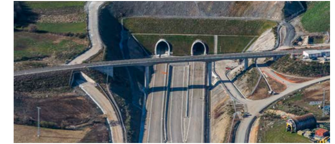
Acceso de la alta velocidad a Galicia (España) Premio San Telmo mejor obra de ingeniería. Colegio de Ingeniería de Caminos, Canales y Puertos de Galicia. Mención de Honor. Fundación Caminos.
