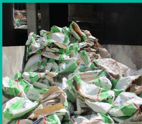
Recogida segregada de sacos en obra.
