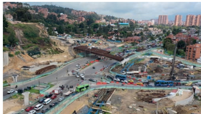
Actuaciones en la Avenida El Rincón y su intersección con la Avenida Boyacá. Bogotá, Colombia.
