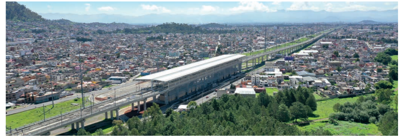
Tramo 1. Tren Interurbano México-Toluca. Estado de México, México.
