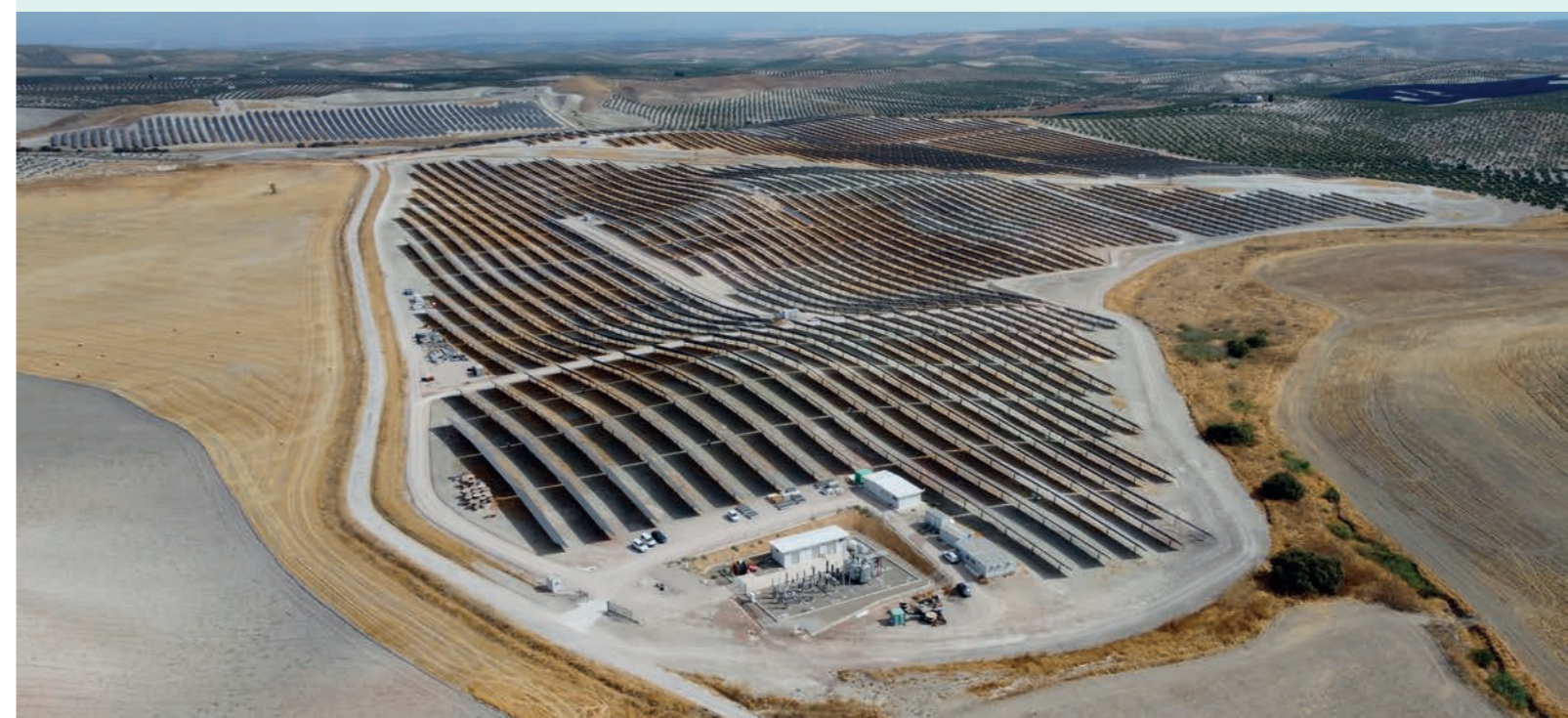
Planta fotovoltaica Olivares, 50MW. Jaén, España.
