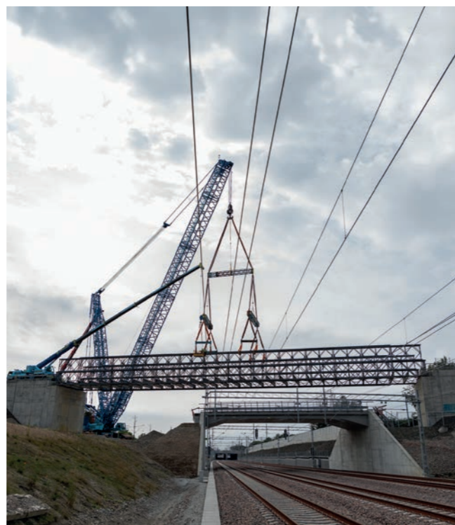
Retirada del puente de 150 toneladas en Åkarp, Suecia. Foto: Niclas Franzén, OHLA/NCC.
